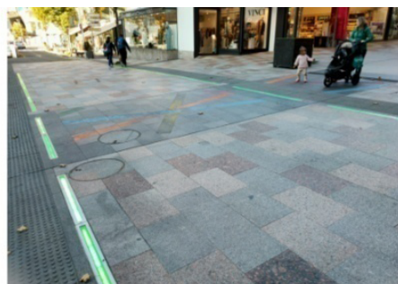
Figura 3.24. Ejemplos de indicadores LED en el suelo para tratar de hacer más visible el paso de peatones con semáforo de regulación a los distraídos con el texting. Izquierda: Sant Cugat del Vallès. Derecha: Escaldes-Engordany.
